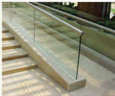
(a) 供轮椅通行的斜坡(右侧)
